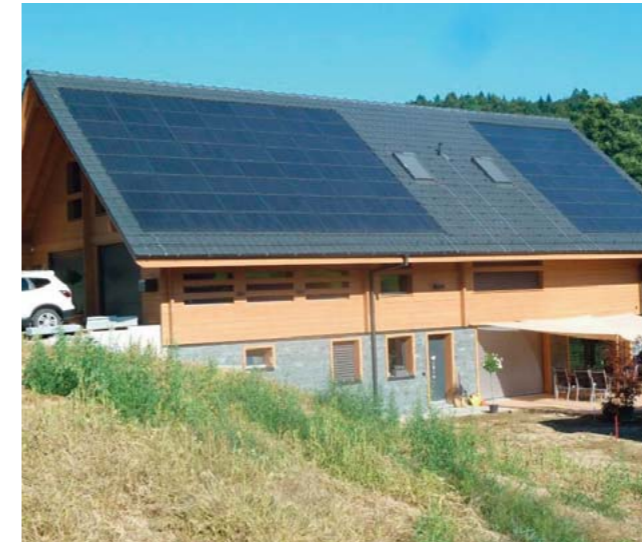
EFH Buuchi, Etzelkofen. Netzgekoppelte Photovoltaik-Indachanlage. Solarmodule 3S Megaslate II. Gesamtleistung: 14,08 kWp.
