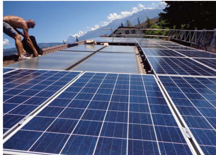
MFH Schwalmernstrasse 9, Thun. Netzgekoppelte Photovoltaik-Aufdachanlage. Solarmodule Trina Honey. Gesamtleistung: 7,14 kWp.
