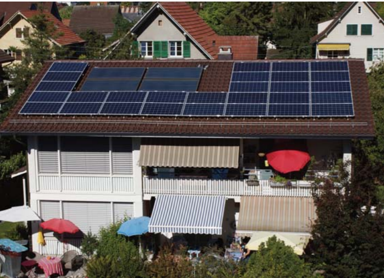
MFH Schwalmernstrasse 9, Thun. Netzgekoppelte Photovoltaik-Aufdachanlage. Solarmodule Trina Honey. Gesamtleistung: 7,14 kWp.
